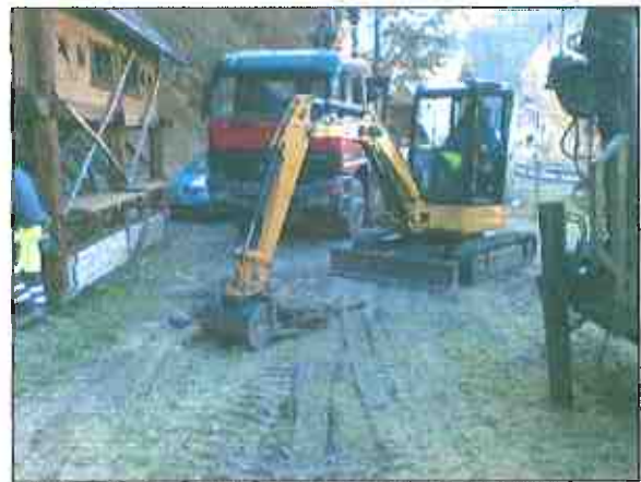
Foto n. 5 – Saggio di scavo SC1, Formino
